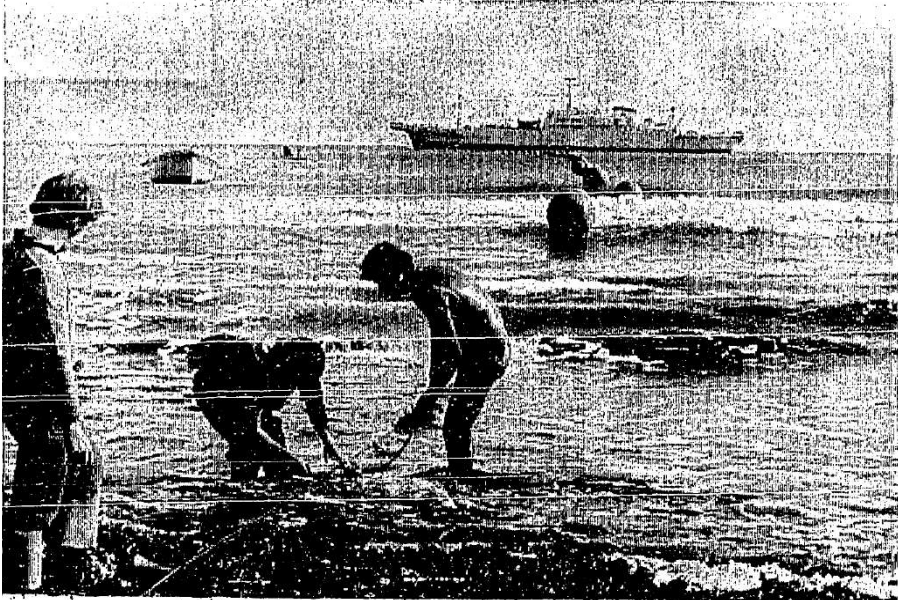
Βατραχάνθρωποι και Έλληνι τεχνικοί στην περσικήν Λάρνακα, κατά την χθεσινήν γόντισιν τών ακραίων τμημάτων ύποβρυχίων καλωδίων συνδέοντων τηλεπικοινωνιακώς την Κύπρον με την Ελλάδα και τόν Λίβανον. Στο βάθος τὸ σκάφος πού εξετάζεται τήν ὄλην ἐργασίαν.
